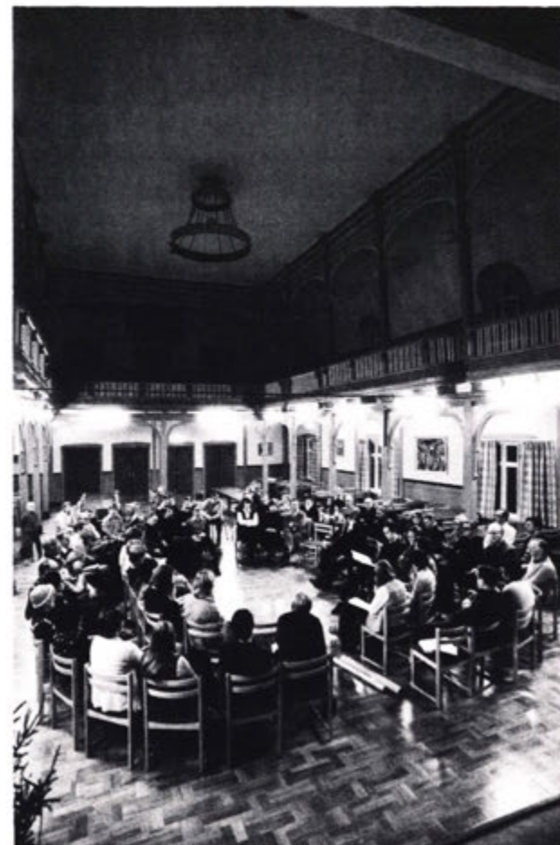
Ombyggnaden av den gamla verkstan kräver ett samsynmöte.
