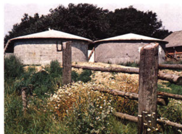
— I tankarna omvandlas djurgödsel, latrin och malet husfallsavfall till metangas och kväverikt, nästan luktfritt, gödslslam, berättar Per om sina två cisterner.
