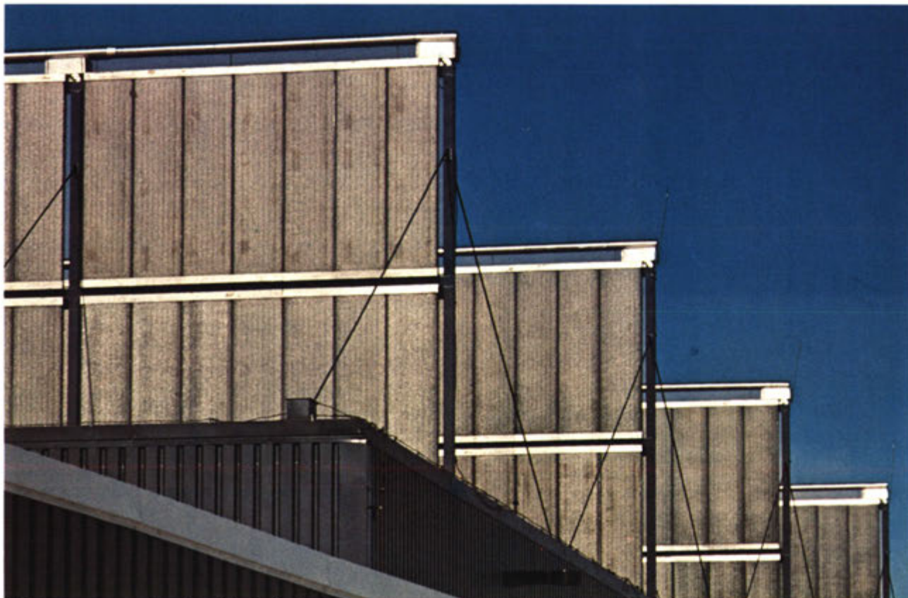
Solfångare ger energi av låg "kvalitet". Dessa stora skärmar är mycket effektiva solfångare och värmer stora industri-lokaler året runt.
