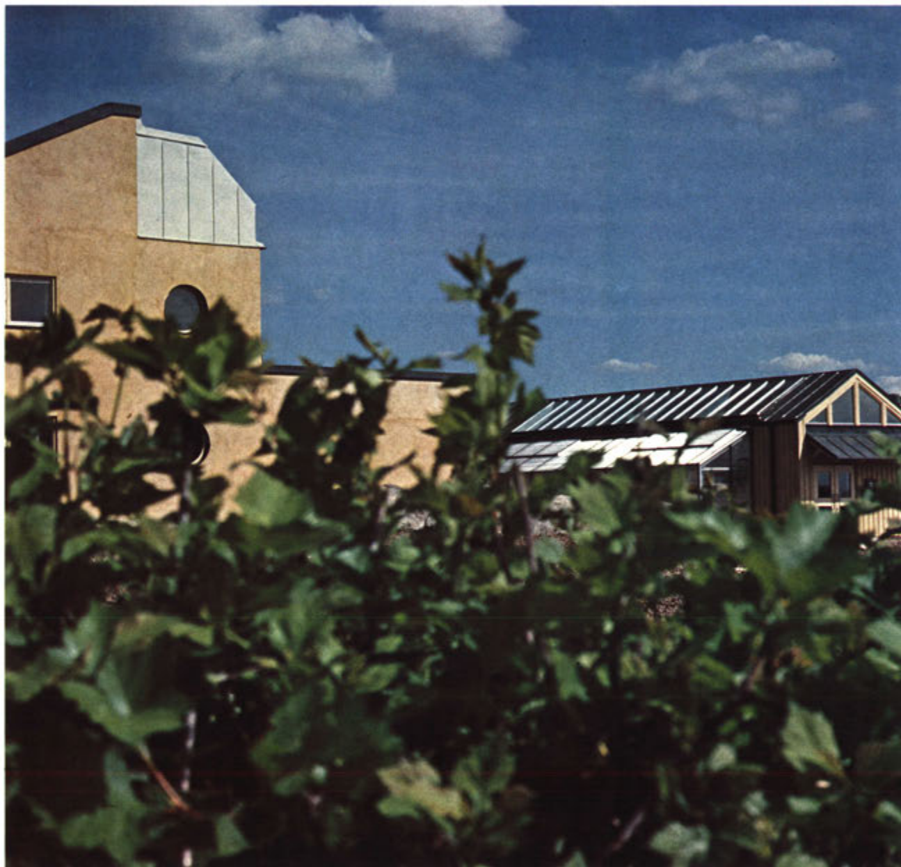
I den nya reningsanläggningen inom Lövhölmens massa- och pappersbruk renas vattnet inom verket. Systemet är nästan slutet för att skona miljön. Inom denna jäsningsanläggning passerar bakvattnet från massafabriken. Där odlas vitrötasvampar, som sedan avfiltrerade blandas in i pappersmassan.
